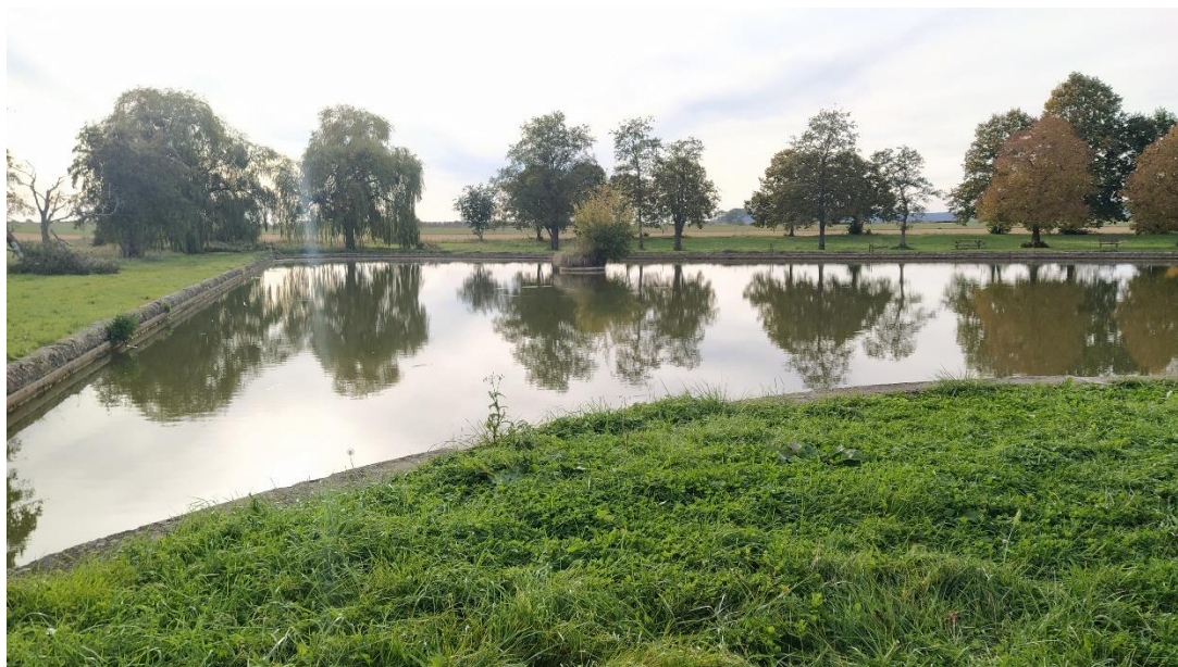
Plan d'eau après travaux (2021)
